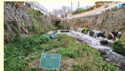
河川洗い堀、応急処置の様子
