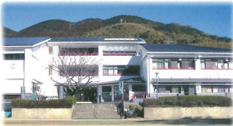
河内小学校 校舎
